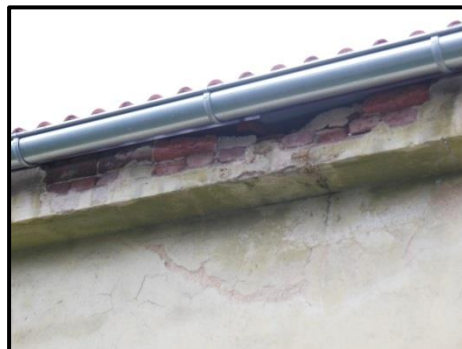
Východní strana kulturního domu
